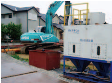
住宅街の河川改修工事現場
